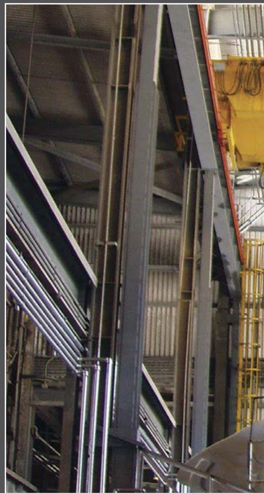
Шинопровод и подвесная система на общепромышленном кране, Колумбия
