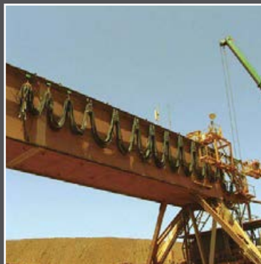
Подвесная система на мостовом перегружателе, Австралия
