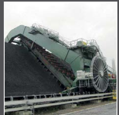
Приводной кабельный барабан на мостовом реклаймере, США
