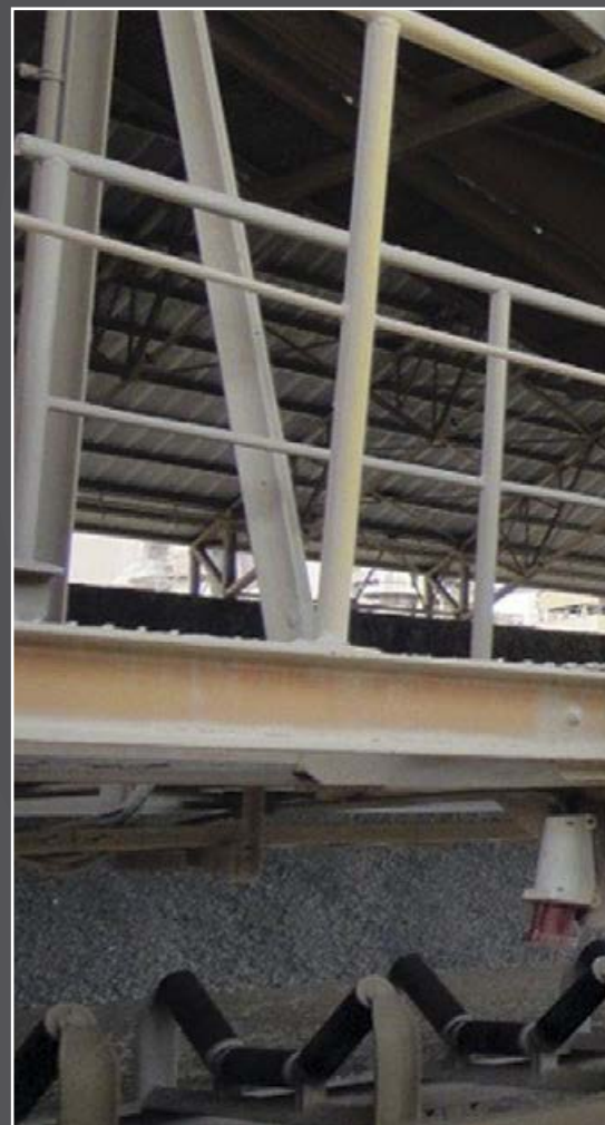
Приводной кабельный барабан на конвейере со сбрасывателем, Венесуэла
